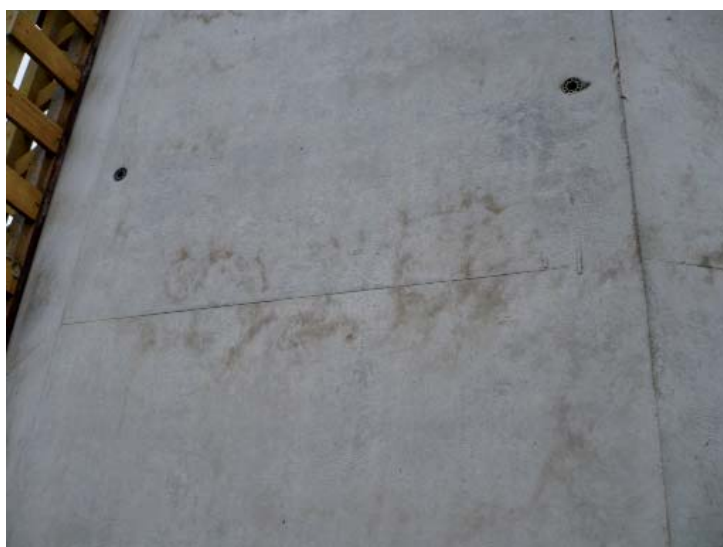
Barevné stopy po odbedňovacím oleji
