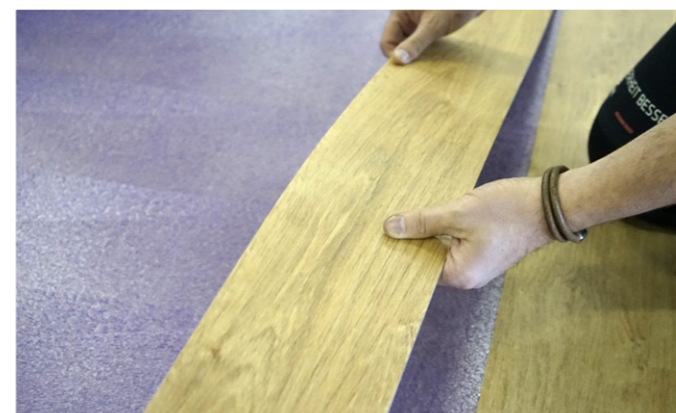
Díky dvouhodinové otevřené době je možné instalovat velké plochy v jednom tahu.
