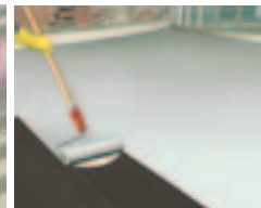
Bílá reflexní barva zvyšuje odrazivost povrchu, zvyšuje energetickou efektivitu objektu.
