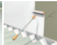
Snadná oprava atiky a dalších konstrukcí
