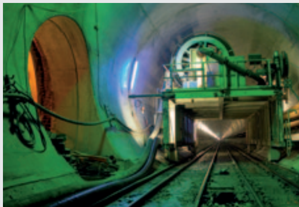
po 100 letech od založení společnosti je znovu 57 km dlouhý Gotthardský tunel významnou stavbou, na které jsou využity produkty Sika. I když je původní výrobek Sika-1 stále v sortimentu vyráběných výrobků, bylo tentokrát použito celé řady nových, moderních produktů.
