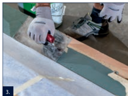
3. Překlopit izolační pásku PB a provést uzavírací vrstvu hmotou RD 2.
