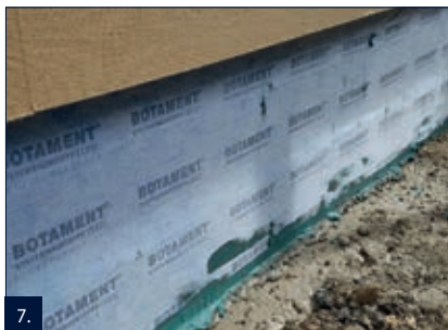
7. Izolační pásku uložit bez zvrásnění.
