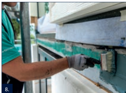
8. Po usazení stěnového elementu na stavbě propojit pásku PB se základovou deskou nebo izolací soklu. Za tímto účelem celoplošně rozprostřít na proschlou uzavírací vrstvu hmotu RD 2.
