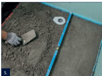
5. Na olejový papír nebo PE fólii vytvořit vodorovnou vrstvu rychlovazným potěrem M 54FM v požadované výšce.
