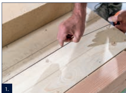
1. Vyměření a označení výšky hydroizolace.
